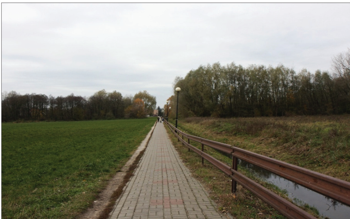
Dojście do kładki od strony ul. Tatarskiej
